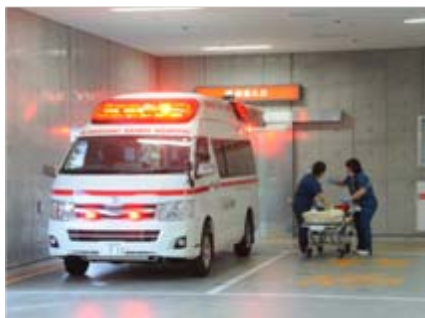
救急車搬入口
